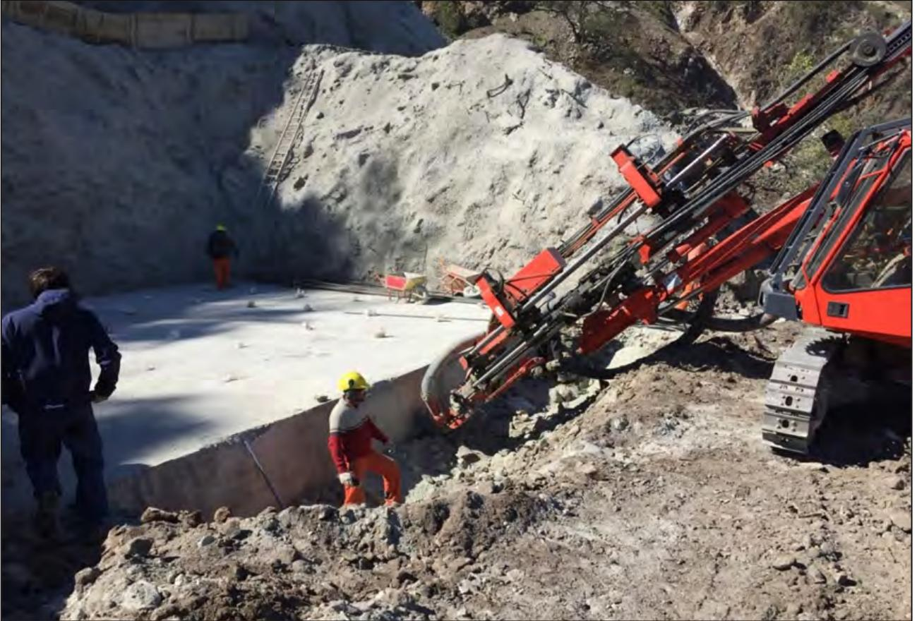
Figura 16. Vista de trabajos de anclaje inclinado en la conformación de la base de asiento del cimiento.
