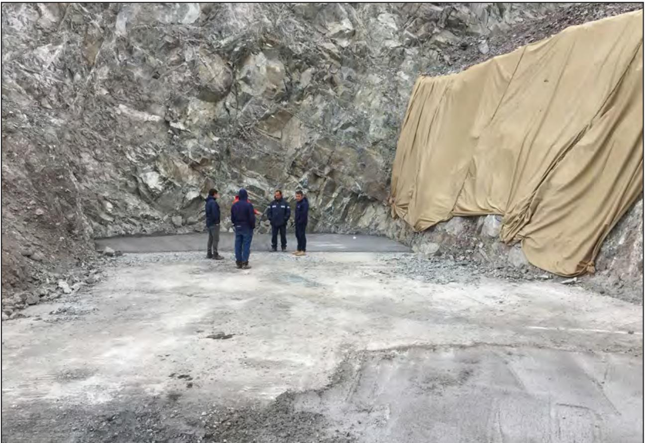
Figura 15. Vista del plano de apoyo de la cimentación cubierto con hormigón de base de asiento.
