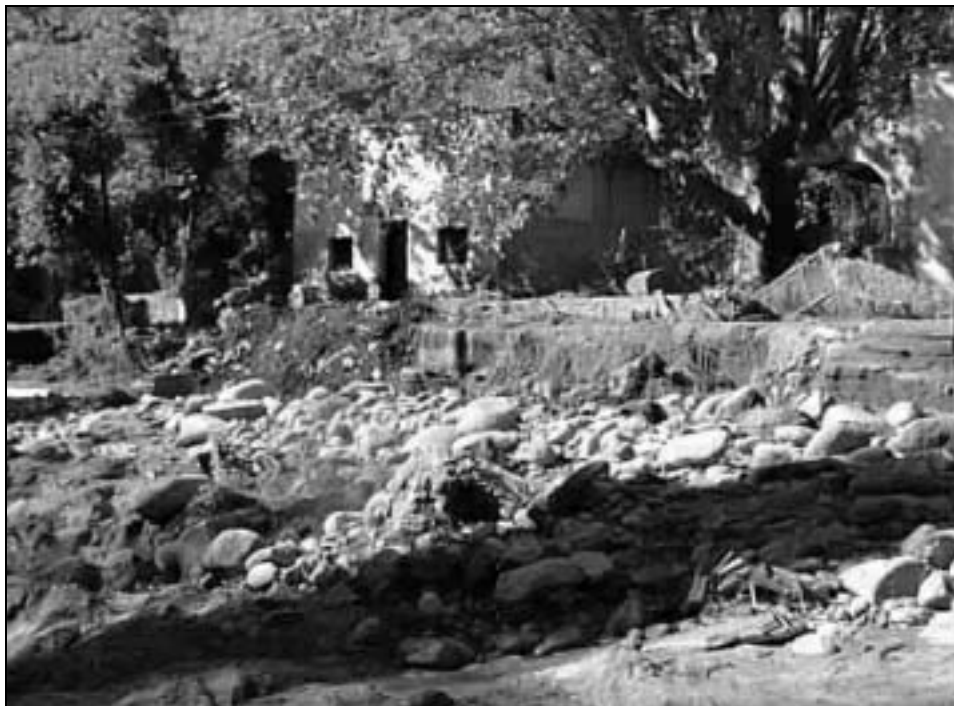
FOTOGRAFÍA 3: VIVIENDA QUE MUESTRA EN SUS PAREDES EL NIVEL DE CRECIDA
