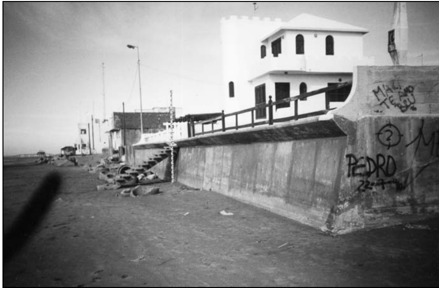
FIGURA 4: EMPLAZAMIENTO DE PAREDONES VERTICALES COMO DEFENSA DE COSTA DEL TIPO ACORAZAMIENTO en la costa de Mar del Tuyú, Municipio de La Costa
