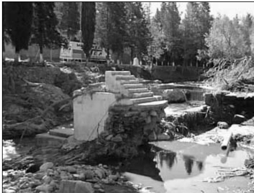
FOTOGRAFÍA 1: PUENTE PEATONAL DESTRUIDO POR LA CRECIDA
