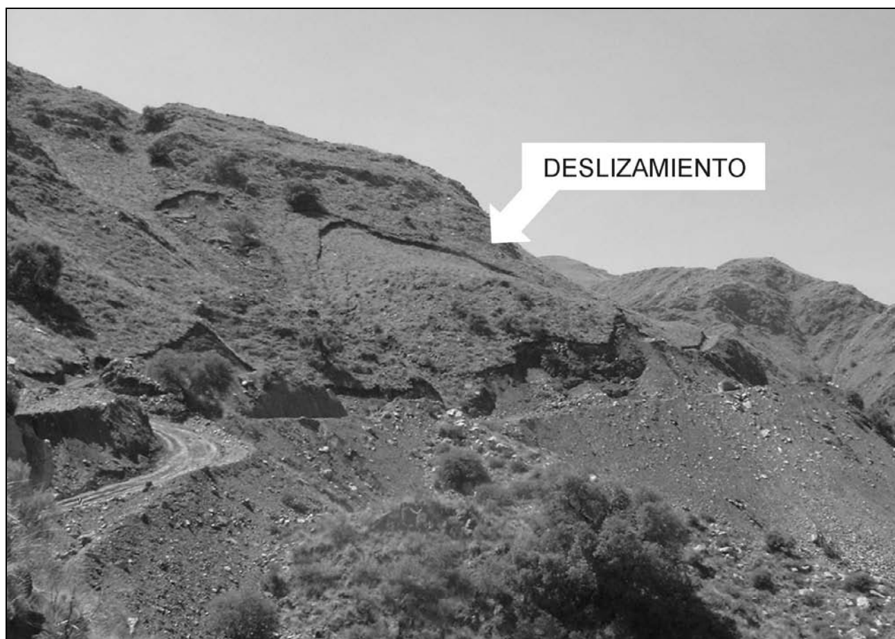
FIGURA 2. VISTA PANORÁMICA HACIA EL SUR DEL DESLIZAMIENTO QUE AFECTA LA NUEVA TRAZA VIAL
