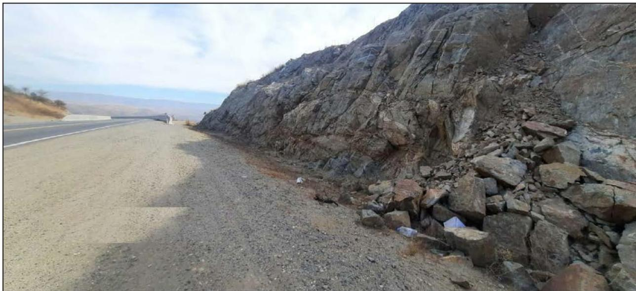
Figura 7. Talud EG17. (31°31'56" - 64°32'02") Desmoronamiento de bloques y obstrucción de cuneta. Vista hacia el Oeste.
