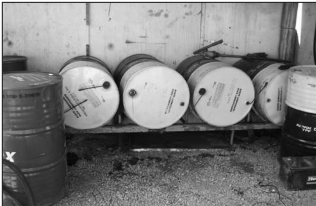
Figura 1. Tambores de aceite sin bandeja de protección del suelo.
