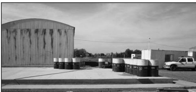
Figura 2. Platea del Depósito de Residuos (el mismo se encuentra en construcción).
