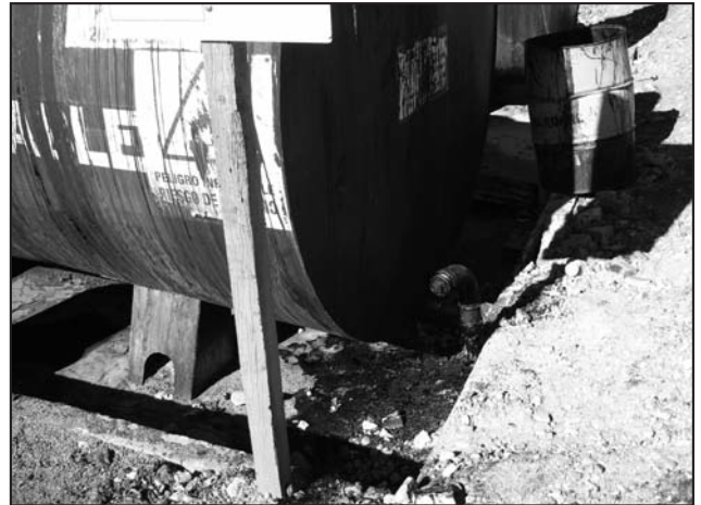
Figura 12. Derrame de asfalto en la carga.
