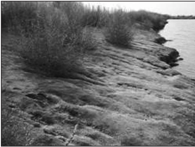
Figura 9c. CVD de categoría 3, húmedas, con residuos, suelos salinizados y taludes inestables. Todas sobre la autopista Rosario-Córdoba.
