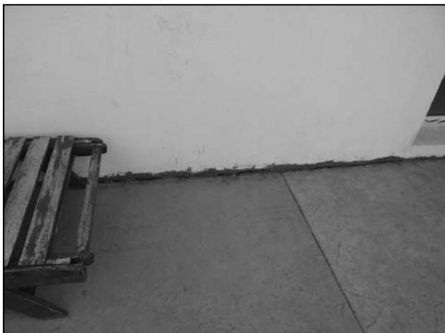
Figura 5. Desplazamiento y rotación en junta en vereda perimetral.
