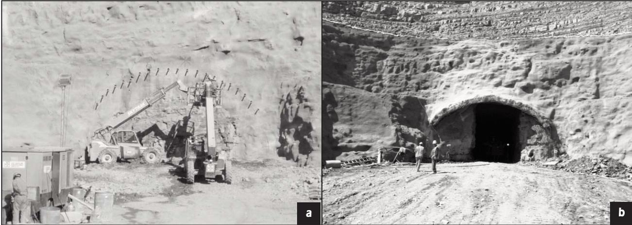
Figura 3. a) Ejecución de paraguas de micropilotes. b) Viga de vinculación del paraguas.
