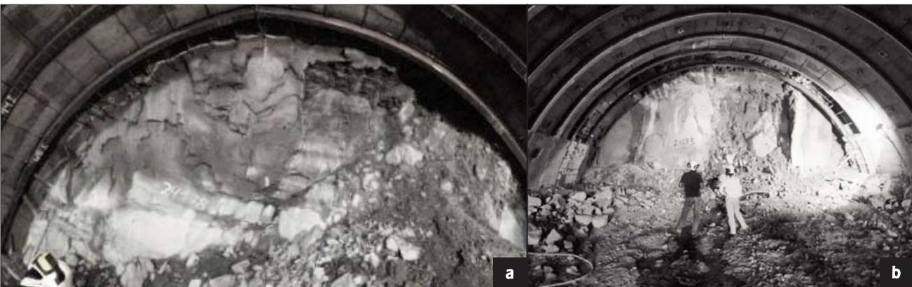
Figura 15. T3. a) Bloques rotados. b) falla paralela al eje longitudinal del túnel.
