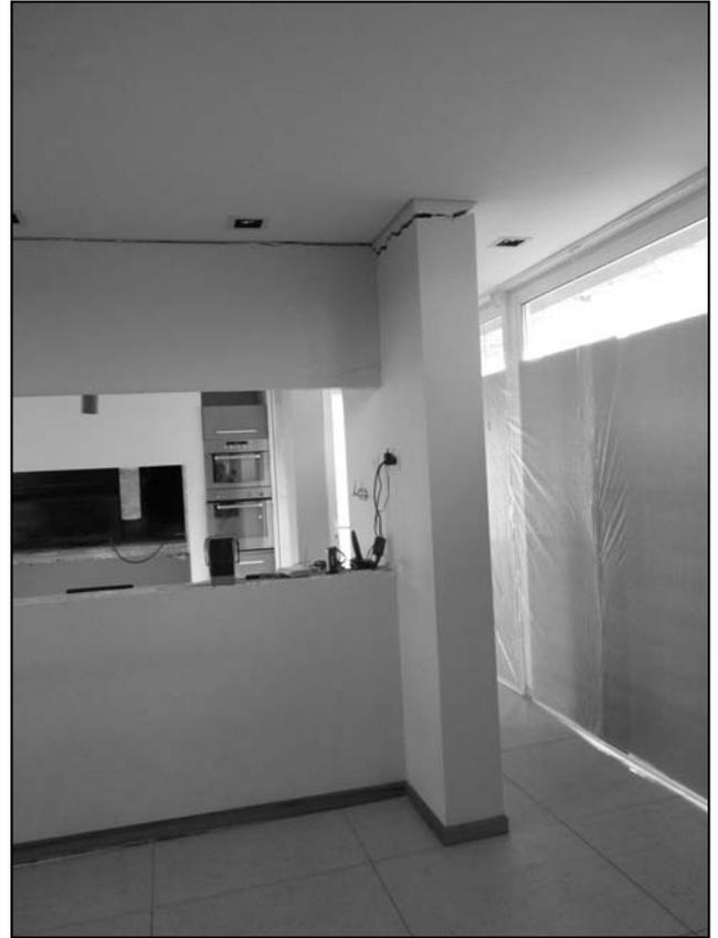
Figura 4. Desplazamiento en muro no estructural.
