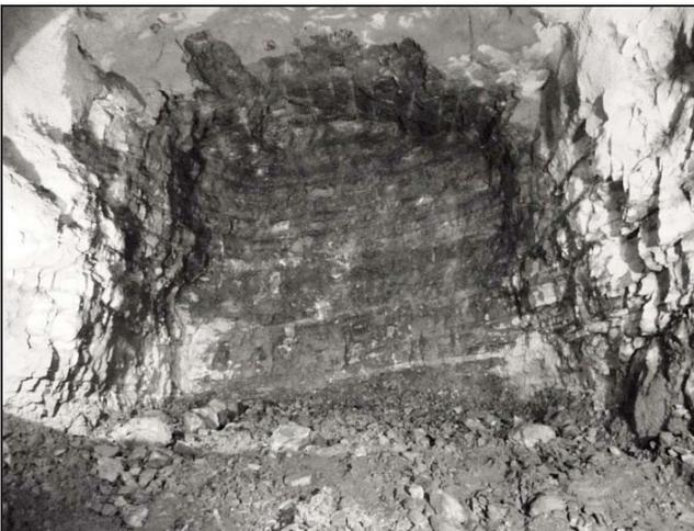
Figura 14. disposición de pelitas del frente de excavación.
