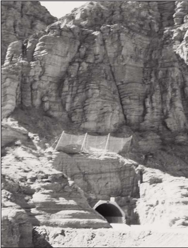
Figura 10. Mitigación de caída de bloques en los portales de salida del T5, con barreras dinámicas.
