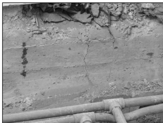
Figura 16. Viga que falló por flexión inversa para la que fue diseñada.
