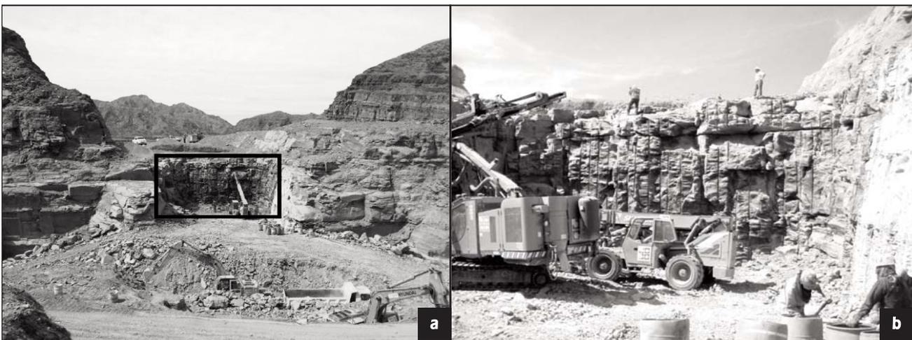
Figura 7. a) Vista de fundación del estribo y b) detalle recuadrado de base del puente arco A2 sobre el río Agua de la Peña.
