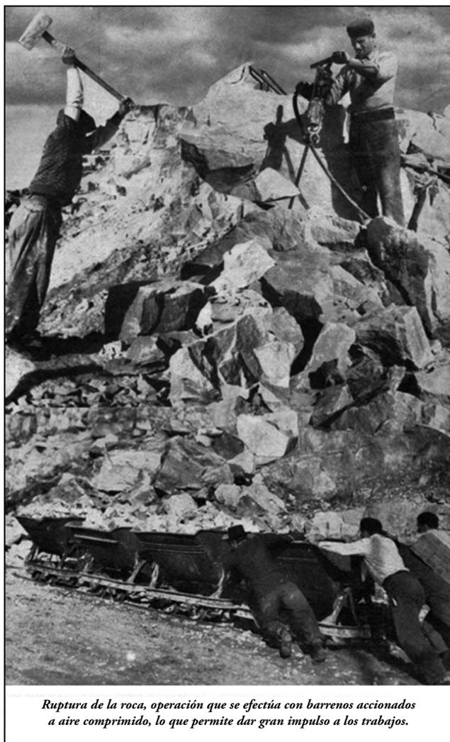
Ruptura de la roca, operación que se efectúa con barrenos accionados a aire comprimido, lo que permite dar gran impulso a los trabajos.
